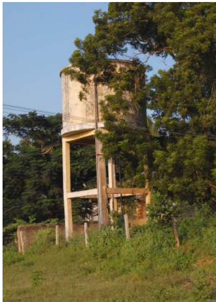
Château d'eau de 1995
