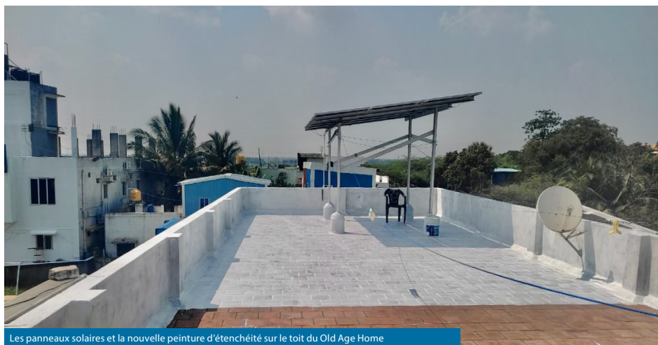
Les panneaux solaires et la nouvelle peinture d'étanchéité sur le toit du Old Age Home
